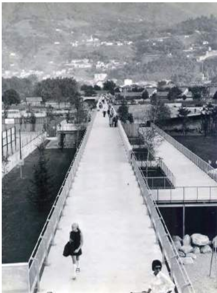
Aurelio Galfetti- Piscinas públicas em Bellinzona, Suíça-1967
