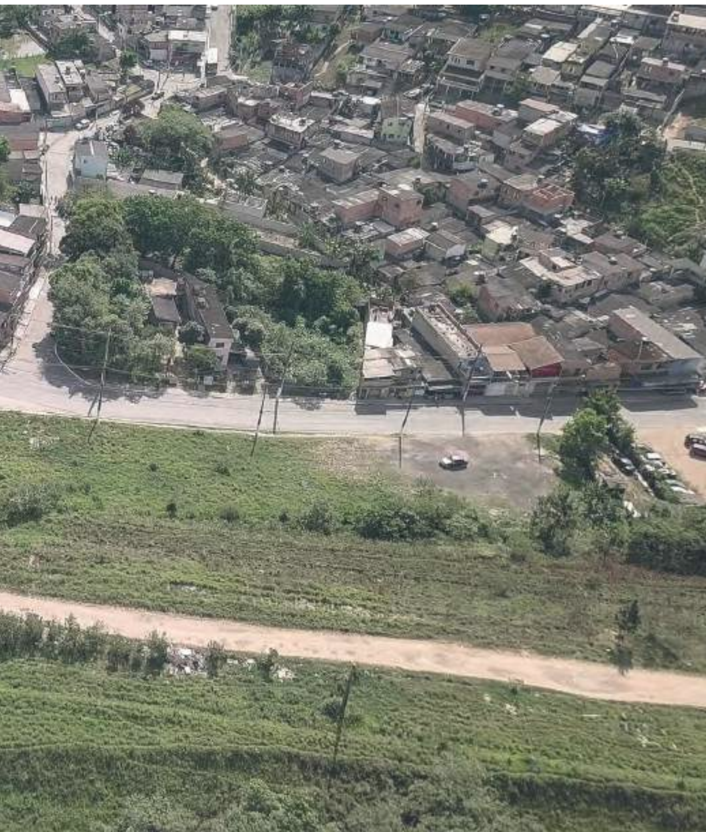
25. Vista da área de implantação das praças de projeto: a praça da feira e a praça de entrada no túnel. As duas áreas já livres de edificações (a exclusão do bar, a ser re-localizado) Foto do drone do Henrique Castro e Silva, outubro 2019
